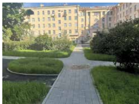
пр. Стачек, 16 лит. А после реконструкции
