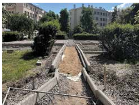
пр. Стачек, 16 лит. А до реконструкции
